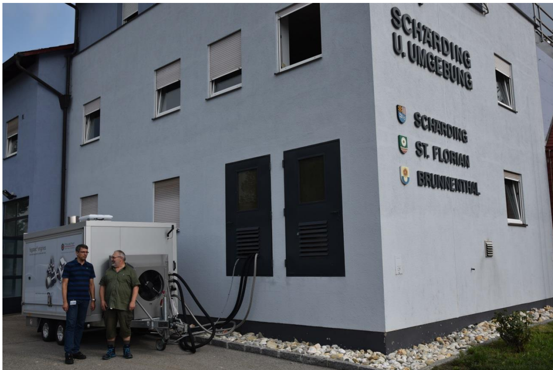
Abbildung 1: Installierter Trailer beim Klärwerk in Schärding
